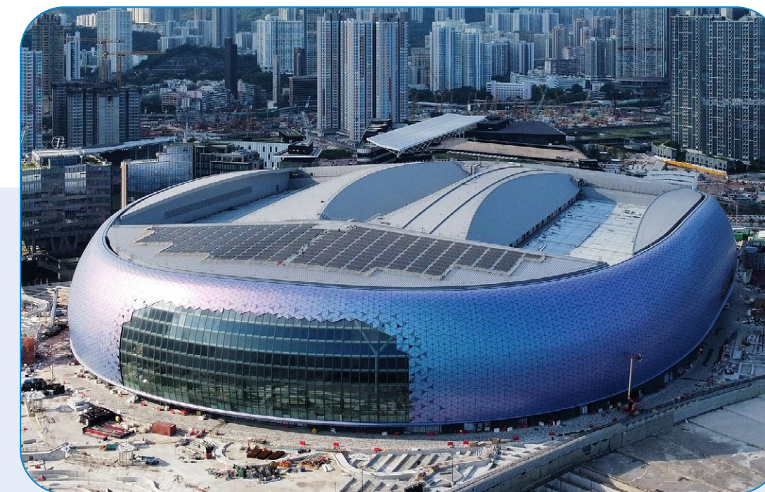
最大型太陽能光伏項目 香港的啟德體育園
