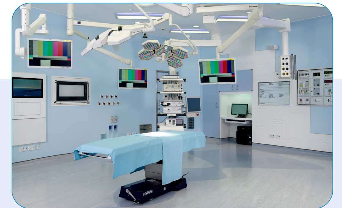
10間模組化手術室 廣華醫院重建計劃（第二期） 將進行之工程
